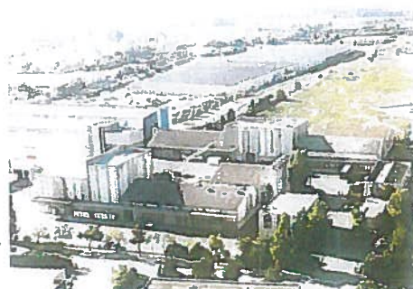
Bureaux de Gemef Industries à Aix en Provence
